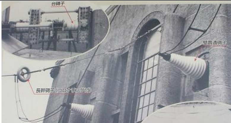
De wanddoorvoerende isolator (doorvoerisolator)
